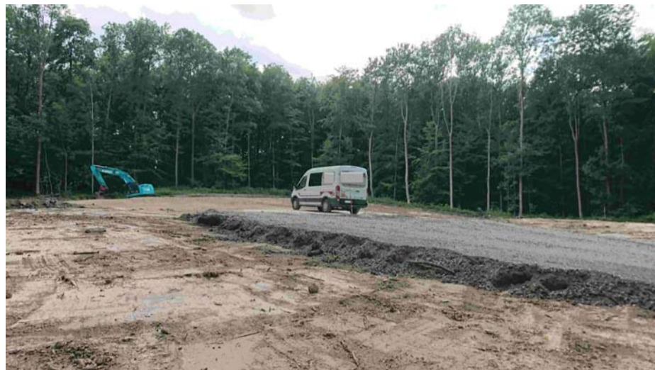
Bohrplatz R11 im Sommer 2020
