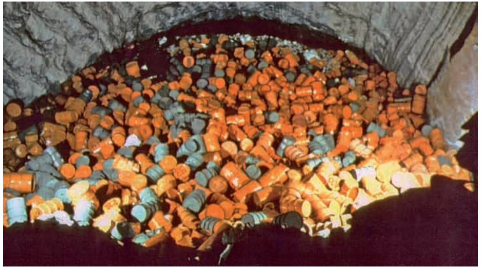
Einlagerungs-„Versuch“: Abkipptechnik vermutlich in Kammer 7 auf der 725-m-Sohle
